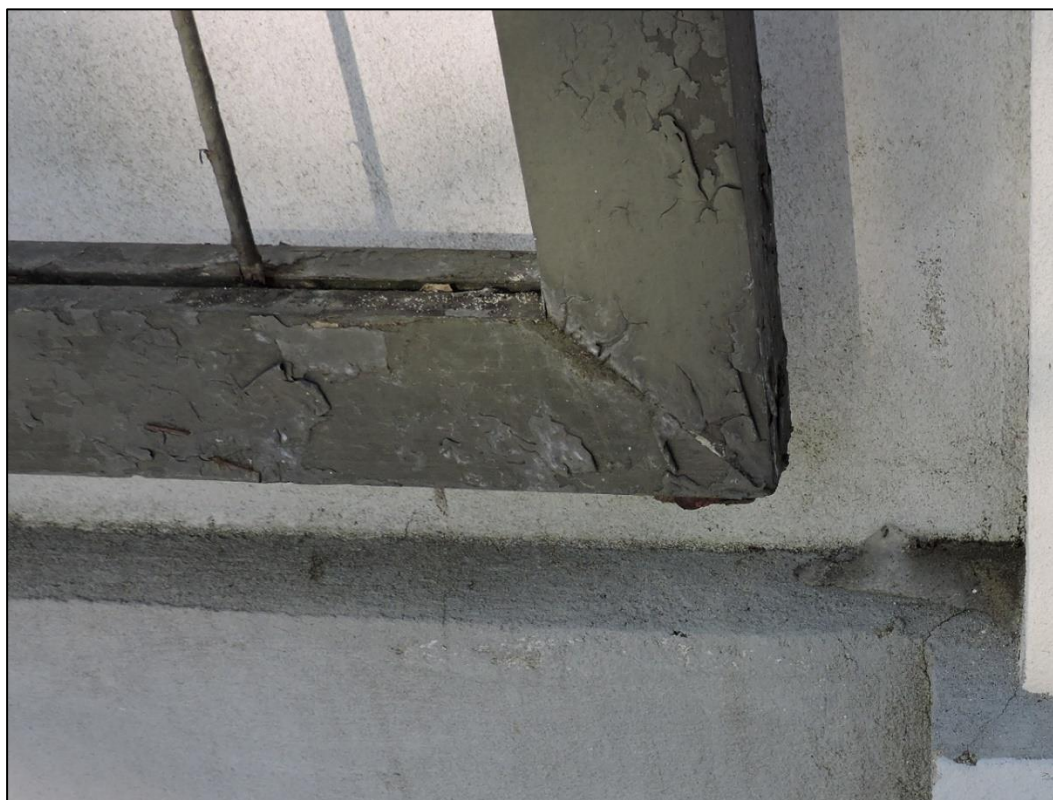
Fot. 31 Dawna Oberża, mur ogrodzeniowy południowy, - fragment metalowej kraty na pnącze, widok złuszczonej farby
