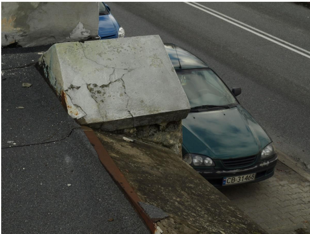
Fot. 30 Dawna Oberża, mur ogrodzeniowy północny – widok popękanej nakrywy betonowej słupa.
