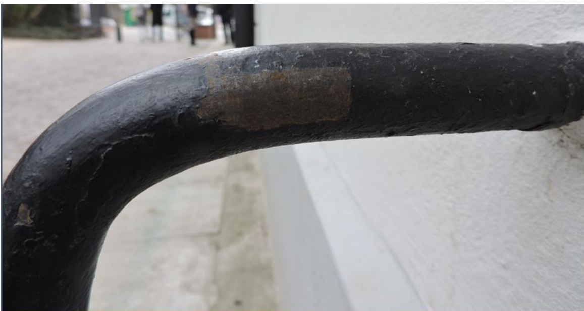
Fot. 19 Dawna Oberża, elewacja zachodnia – widok szczegółowy żelaznego drągu, pod wierzchnią farbą produkty korozji
