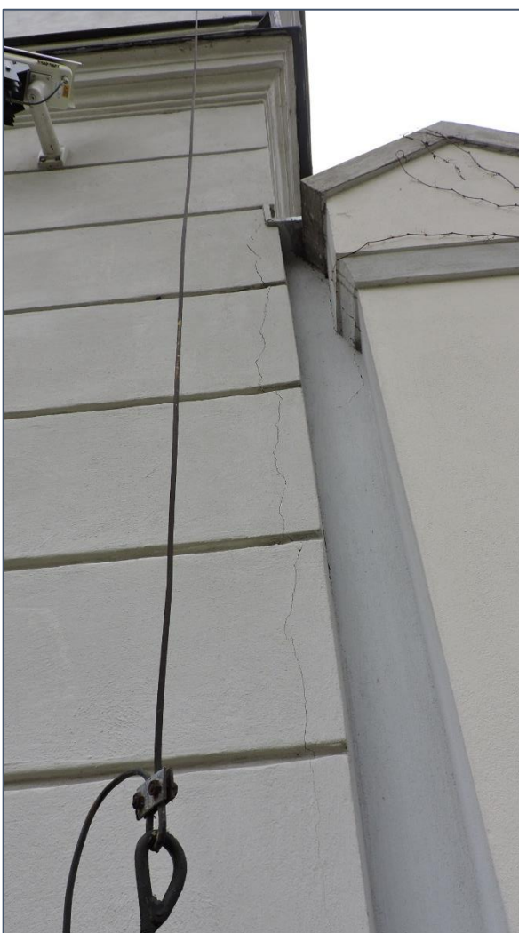
Fot. 8 Dawna Oberża, elewacja południowa – widok szczegółowy, pęknięcie przy murze ogrodzeniowym
