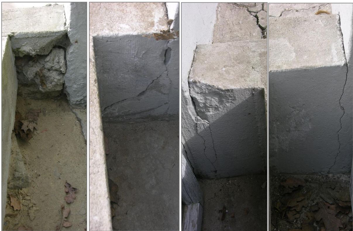
Fot. 17. Dawna Oberża, przykłady pęknięć i ubytków materiału na styku opaski betonowej z elewacją budynku.
