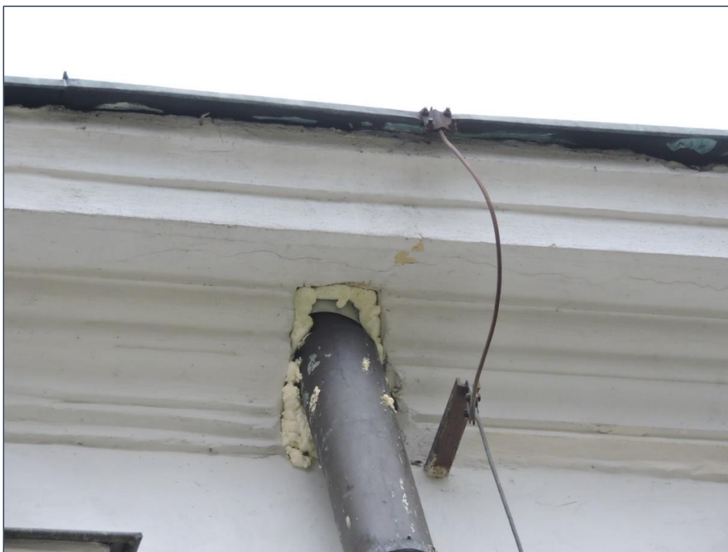
Fot. 9 Dawna Oberża, elewacja południowa – widok szczegółowy styku rury spustowej z gzymsem kordonowym
