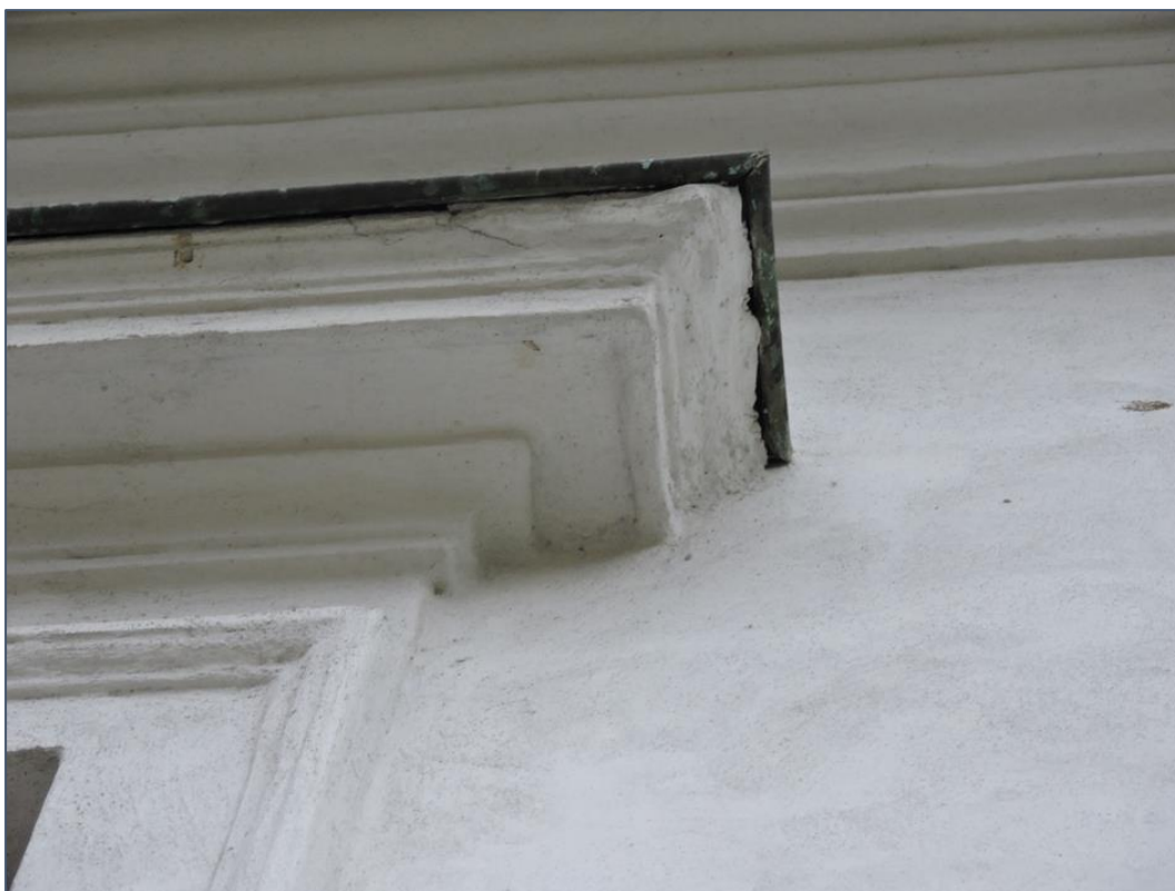
Fot. 11 Dawna Oberża, elewacja południowa – widok szczegółowy niewyprowadzonego profilu nadokiennego
