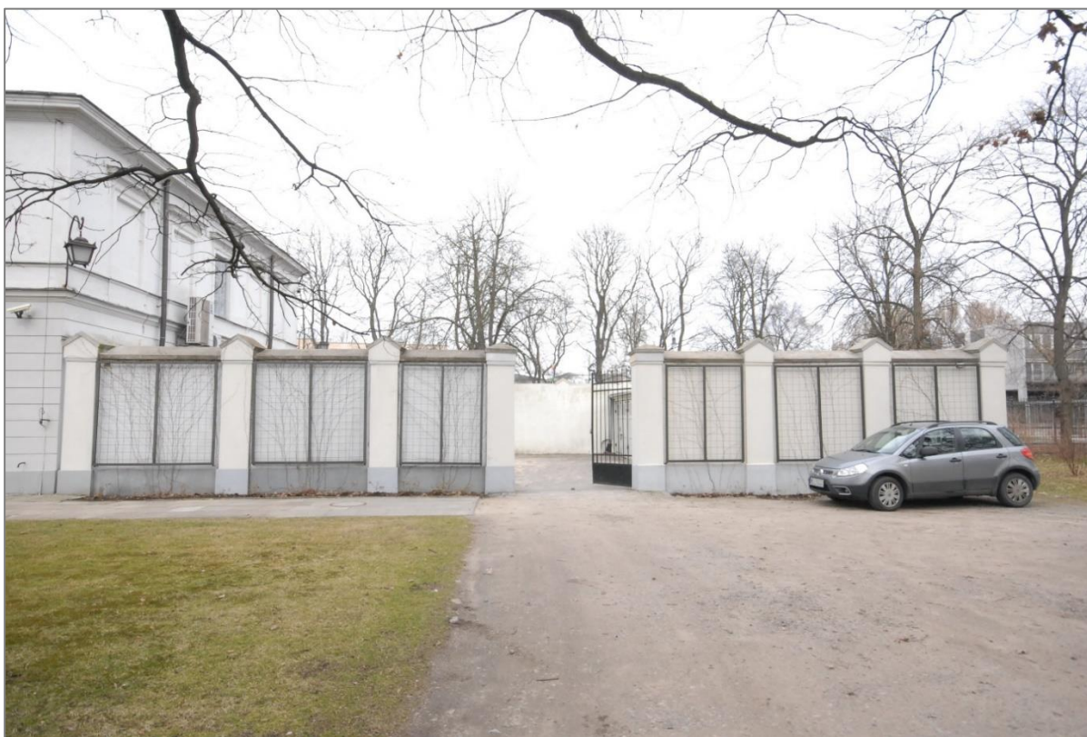
Fot. 21 Dawna Oberża, mur ogrodzeniowy od strony południowej – widok ogólny.
