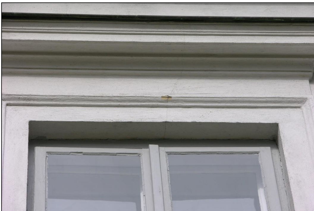
Fot. 7 Dawna Oberża, elewacja południowa – widok szczegółowy pęknięcia na nadprożu okiennym
