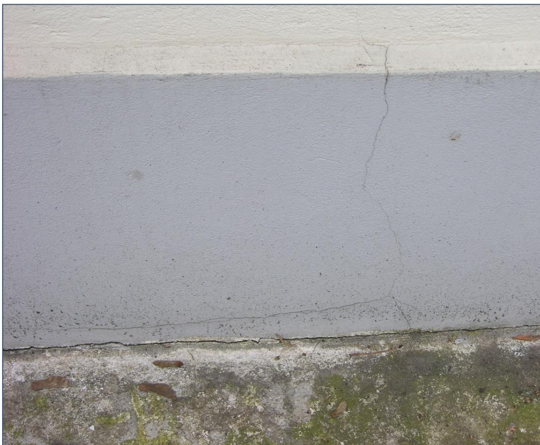
Fot. 27 Dawna Oberża, mur ogrodzeniowy wschodni – widok pęknięć wyprawy tynkarskiej w strefie cokołu
