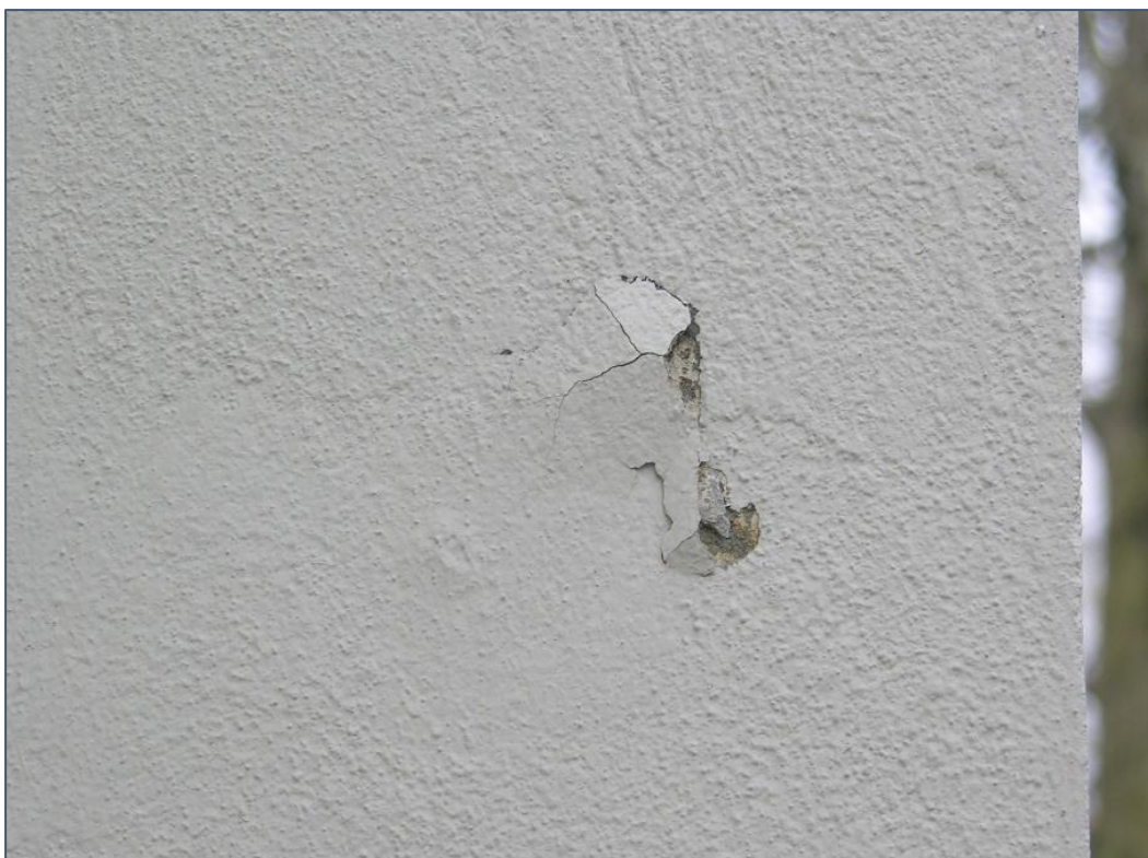
Fot. 26 Dawna Oberża, mur ogrodzeniowy wschodni – widok pęknięć wyprawy tynkarskiej
