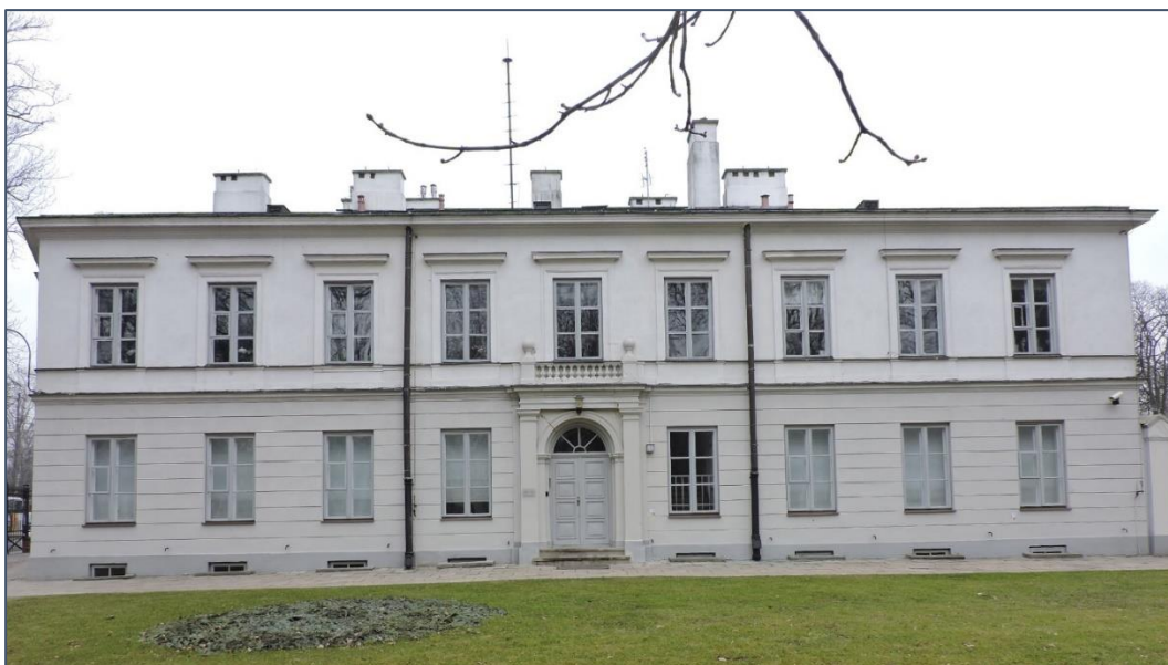
Fot. 1 Dawna Oberża – widok ogólny elewacji południowej
