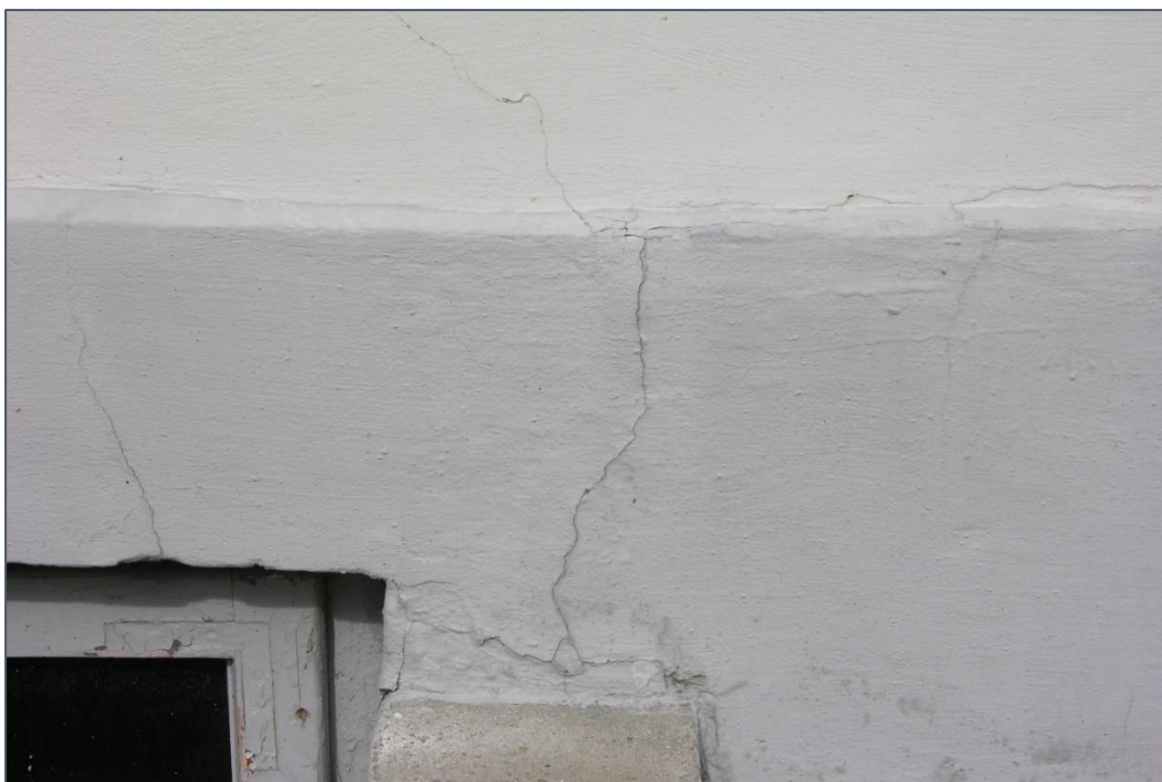
Fot. 14 Dawna Oberża, elewacja południowa – widok szczegółowy, rysy na wyprawie tynkarskiej
