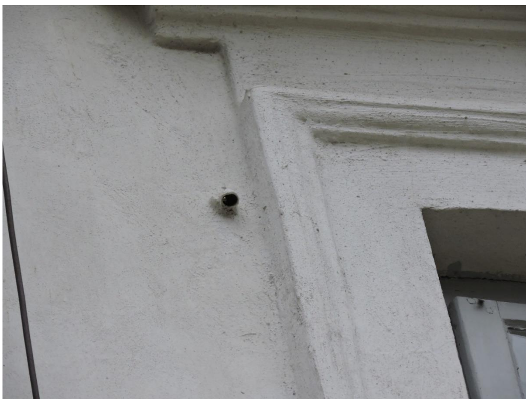
Fot. 12 Dawna Oberża, elewacja południowa – widok szczegółowy dawnej instalacji
