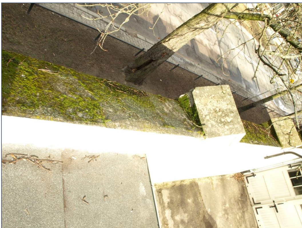
Fot. 29 Dawna Oberża, mur ogrodzeniowy północny – widok nakrywy betonowej pokrytej nawarstwieniami mikroflory
