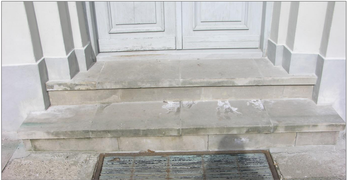
Fot. 16 Dawna Oberża, elewacja północna – widok schodów z piaskowca
