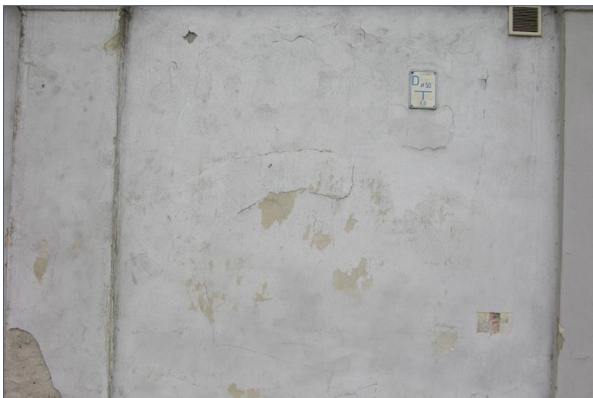
Fot. 25 Dawna Oberża, mur ogrodzeniowy północny – widok pęknięć wyprawy tynkarskiej
