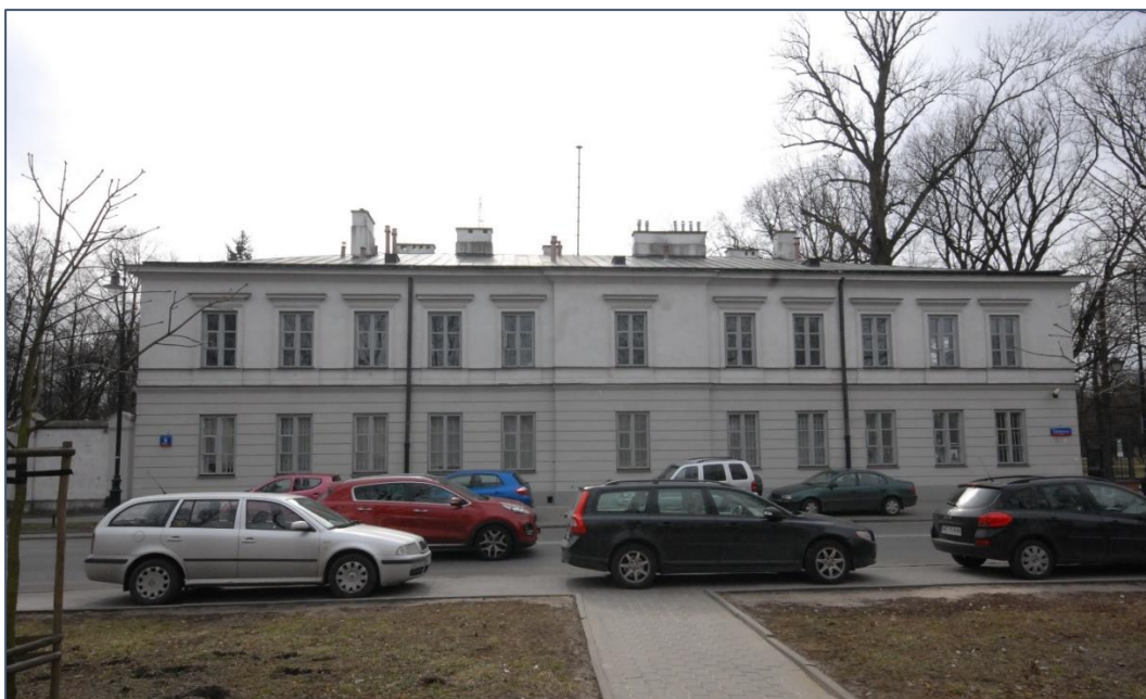
Fot. 3 Dawna Oberża – widok ogólny elewacji północnej
