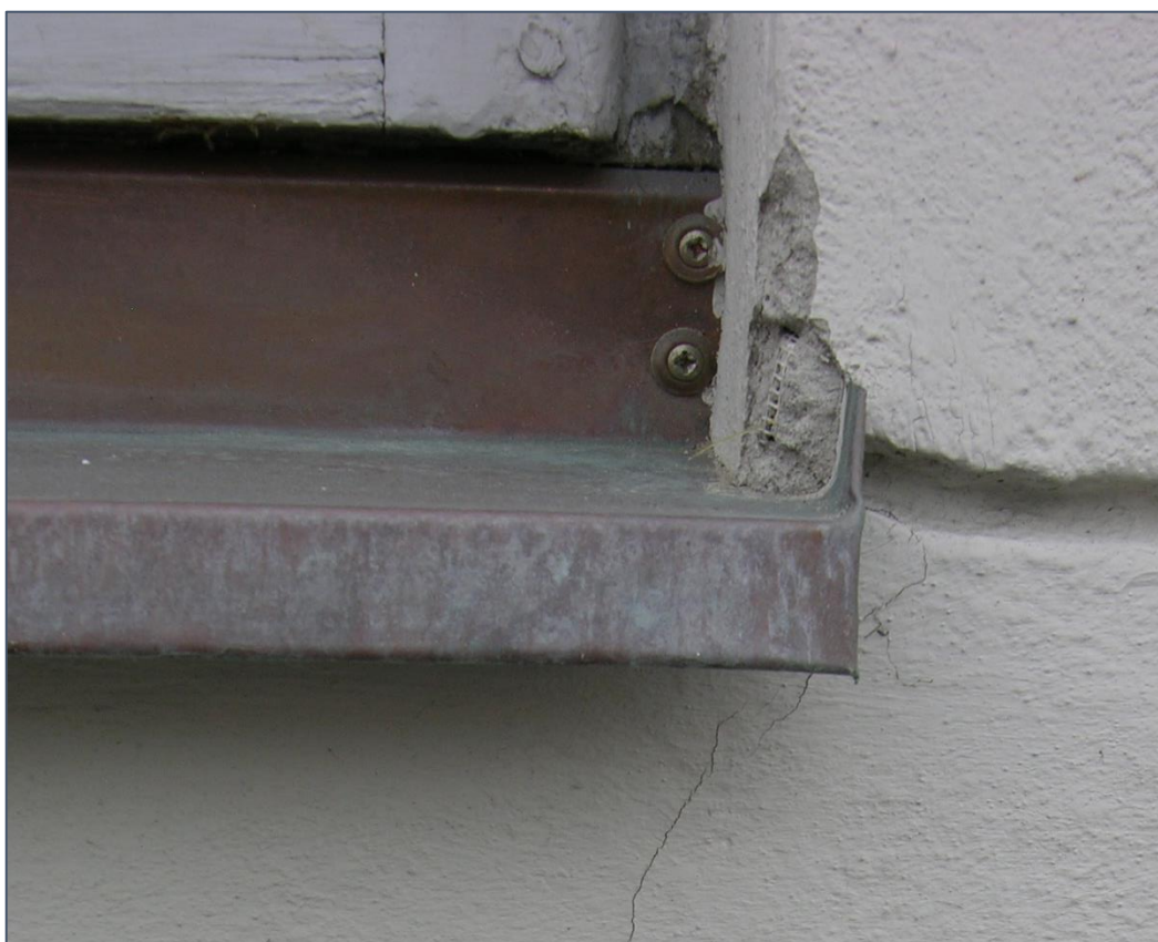
Fot. 15. Dawna Oberża, elewacja północna – widok szczegółowy, ubytki i pęknięcia na styku z wyprawą tynkarską.
