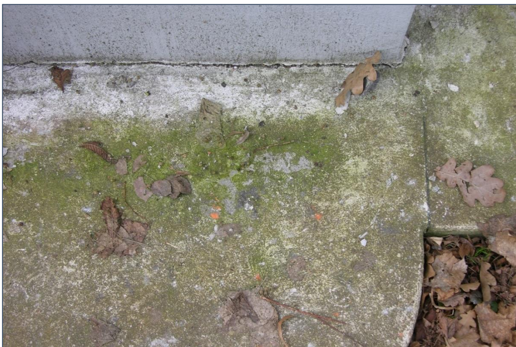
Fot. 28 Dawna Oberża, mur ogrodzeniowy wschodni – widok nawarstwień mikroflory na opasce betonowej przy murze ogrodzeniowym
