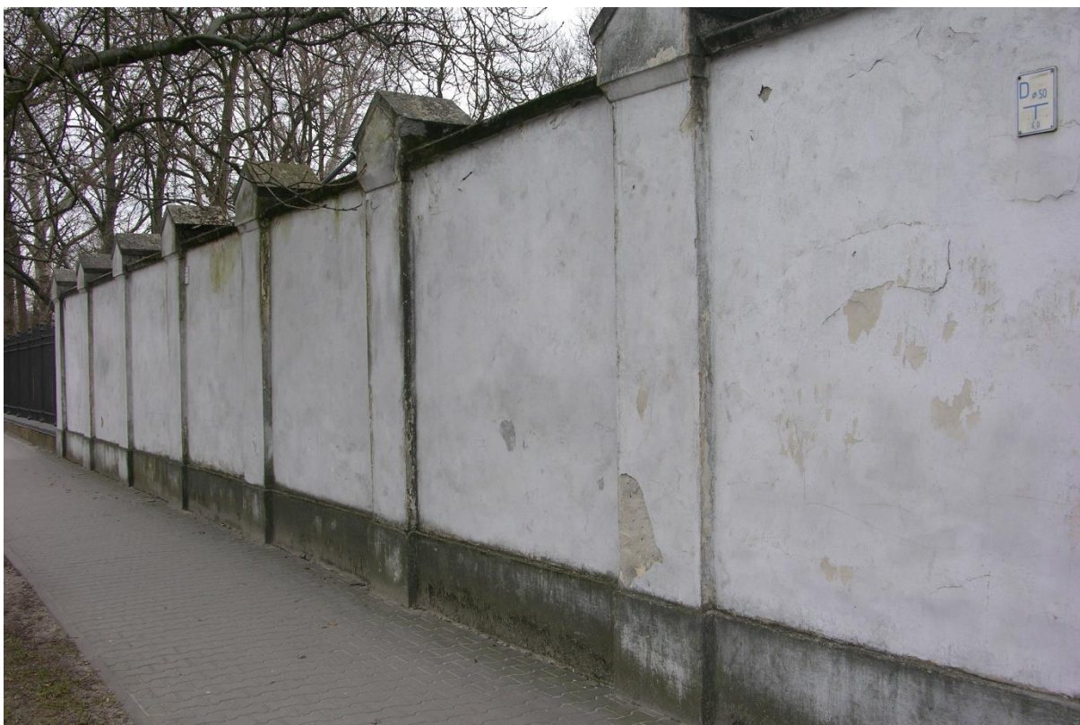
Fot. 24 Dawna Oberża, mur ogrodzeniowy od strony północnej – widok ogólny
