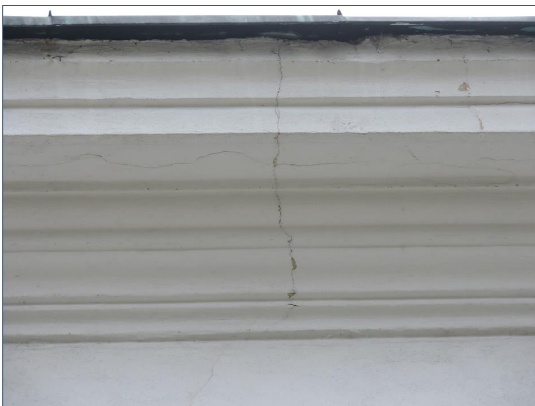
Fot. 6 Dawna Oberża, elewacja południowa – widok szczegółowy pęknięć na gzymsie kordonowym.
