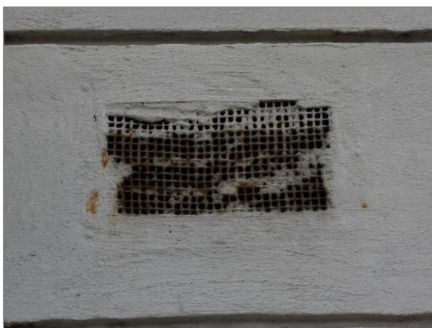
Fot. 18 Dawna Oberża – widok szczegółowy kratki wentylacyjnej pokrytej cienkowsarstwową wyprawą
