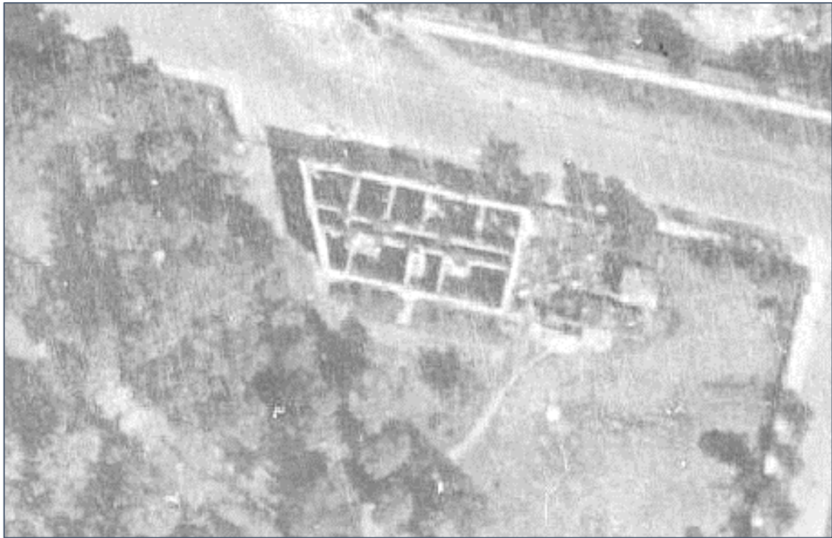
Rys. 5 Budynek Dawnej Oberży w 1945. Widoczne zniszczenie zabudowań po stronie wschodniej i brak zadaszenia 8 .
