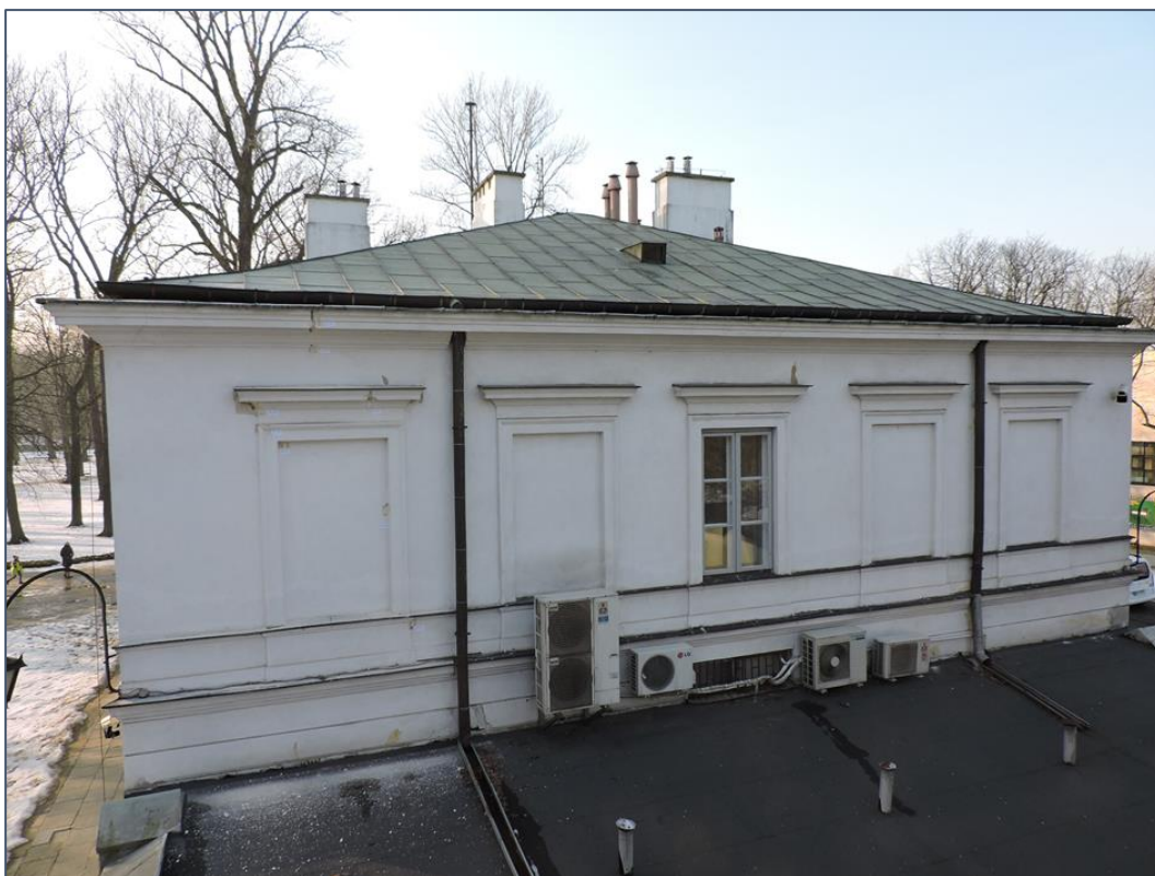
Fot. 5. Dawna Oberża – widok ogólny II kondygnacji elewacji wschodniej.
