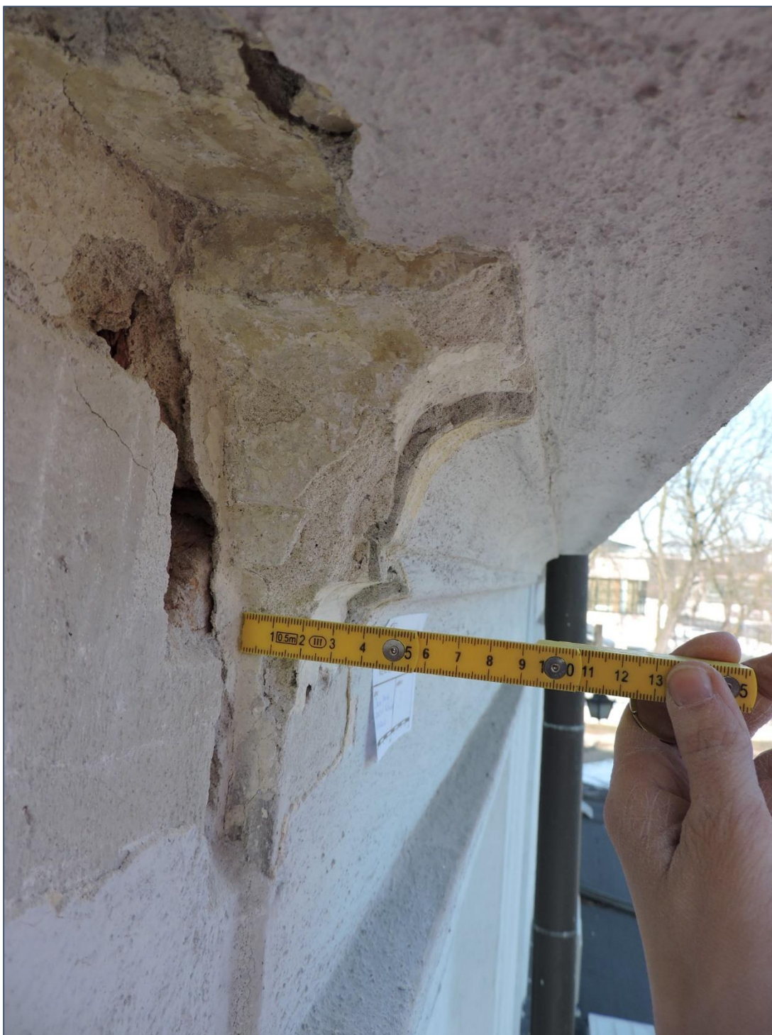
Fot. 13 Dawna Oberża, elewacja wschodnia – widok szczegółowy profilu nadokiennego, na oryginalnych wyprawach nadłożona zaprawa cementowo-wapienna.
